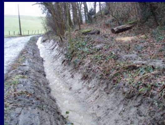
Curage d'un caniveau
