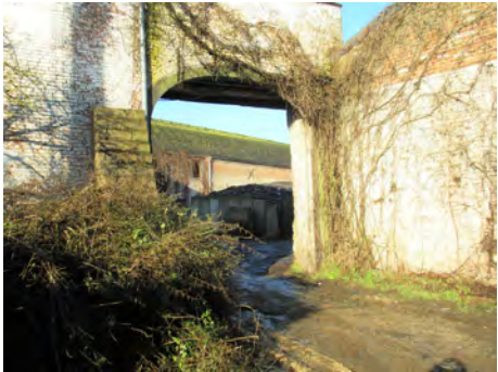
2. Ferme des Fossés: rue de la Tourterelle
